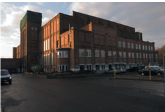
Links: Noord- en oostgevel van het fabrieksgebouw. Rechts: Zuid- en westgevel. Josiane Kisteman
