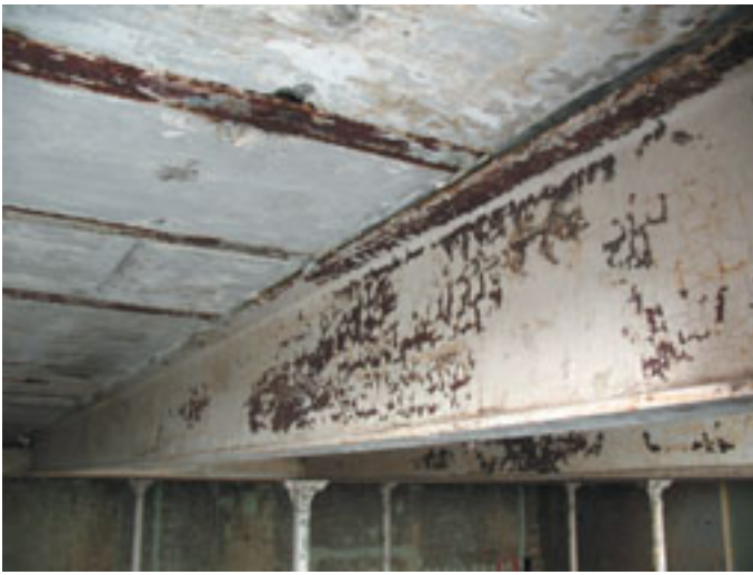
Links: Vloeropbouw fabriekshallen. Rechts: Schacht zuidgevel.
