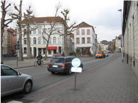
Foto 5: Aanliggend verhoogde fietspaden in Ottogracht
