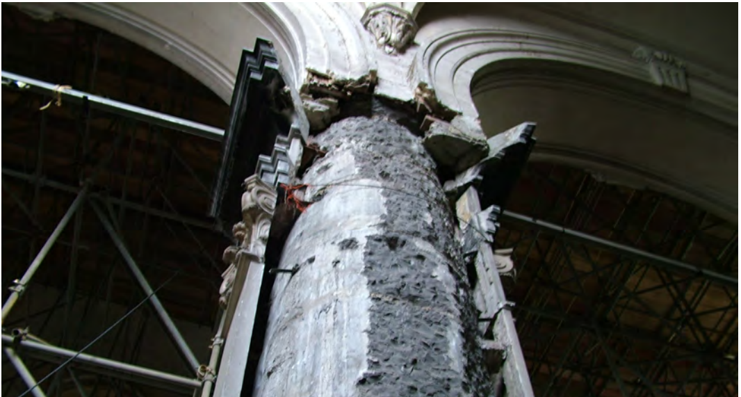
Fig.10. Beeld op de pijlers van het middenschip waarop men duidelijk het weggekapte deel van de pijler kan zien, waar in 1801 boekenrekken werden tegen gebouwd. (foto auteurs)
