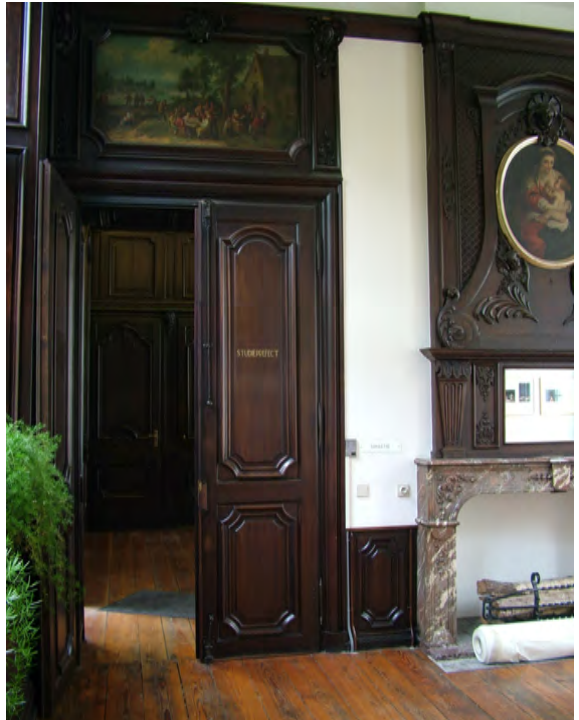
Fig.4. Een beeld van de voormalige abtsvertrekken langs de Ottogracht in de huidige toestand.(foto door de auteurs)
