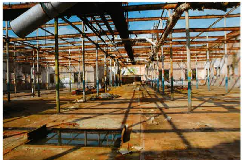
Oktober 2006. De afbraak is in volle gang, van de oude plooihaal blijft enkel nog een stalen skelet over...
