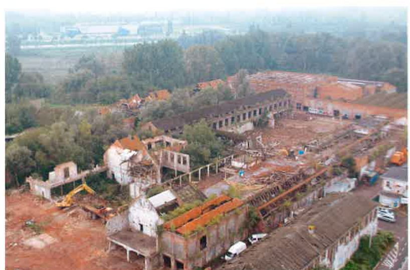
Luchtfoto van de blekerij tijdens de slopingswerken.
