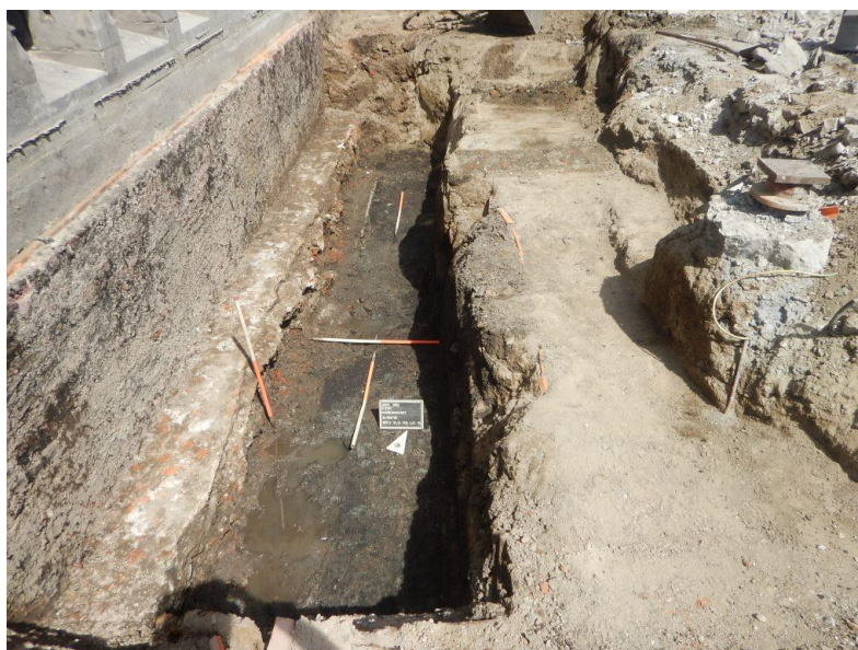
Fig. 23: Overzicht werkput 2, vlak 3
