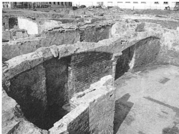
Fig. 5: Overzichtsfoto Kelder 30. Hier is duidelijk te zien hoe de oorspronkelijke ruimte in twee werd opgedeeld door boogstructuren die later werden dichtgebouwd met baksteen (© Stad Gent, Dienst Stadsarcheologie).
