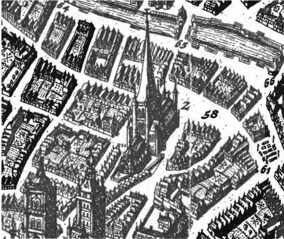
Afbeelding 9: zicht op het koor en de noordgevel van de Sint-Niklaaskerk. 50
