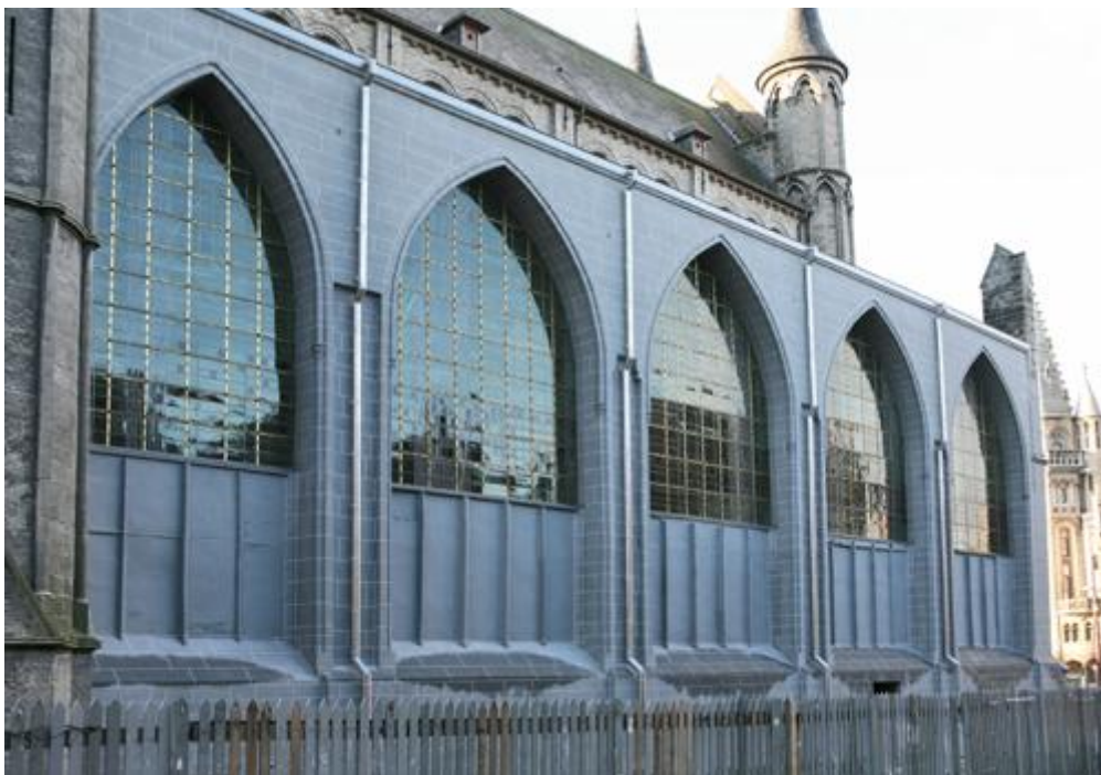
Afbeelding 59: de gerestaureerde gevel van de noorderbeuk. 316
