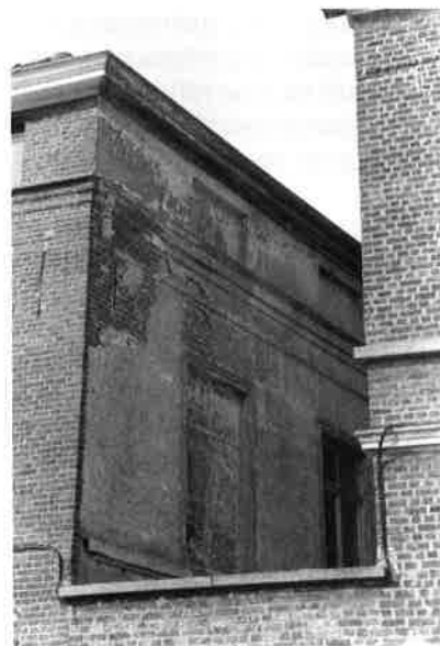
Zijgevel van het dubbelhuis in 1860 ingericht op perceel 2297 in een bedrijfsgebouw van de vroegere brouwerij – mouterij, later katoenfabriek. Bemerkt de gedichte vensters die vroeger uitgaven op het uiteinde van de Groenstraat (rechts) (foto C. Puttevils)
