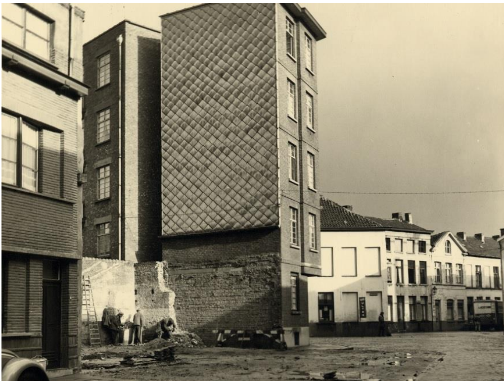
Figuur 29 Krotwoningen zijn gesloopt naast het appartementsgebouw uit 1934 op de hoek van Dobbel Slot en de Baviaanstraat, gebouwd voor de Gentse Haard. 31
