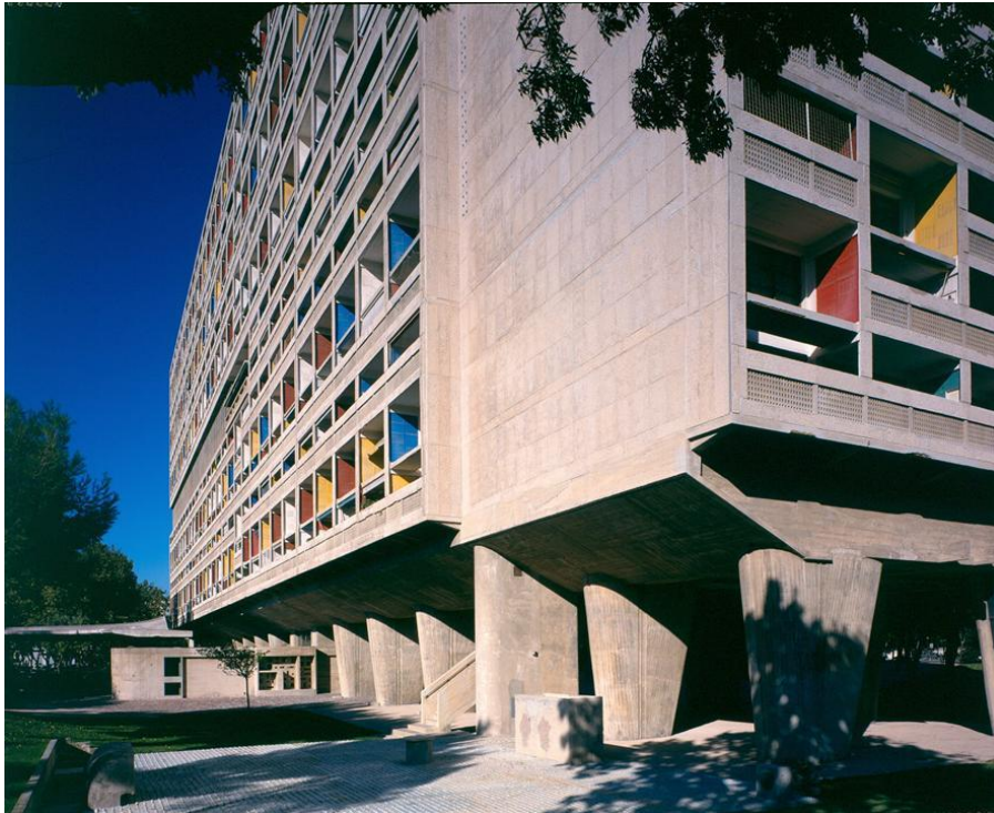
Figuur 22 Architect Le Corbusier, Unité d'Habitation, Marseille, 1952, betonnen piloti's 24
