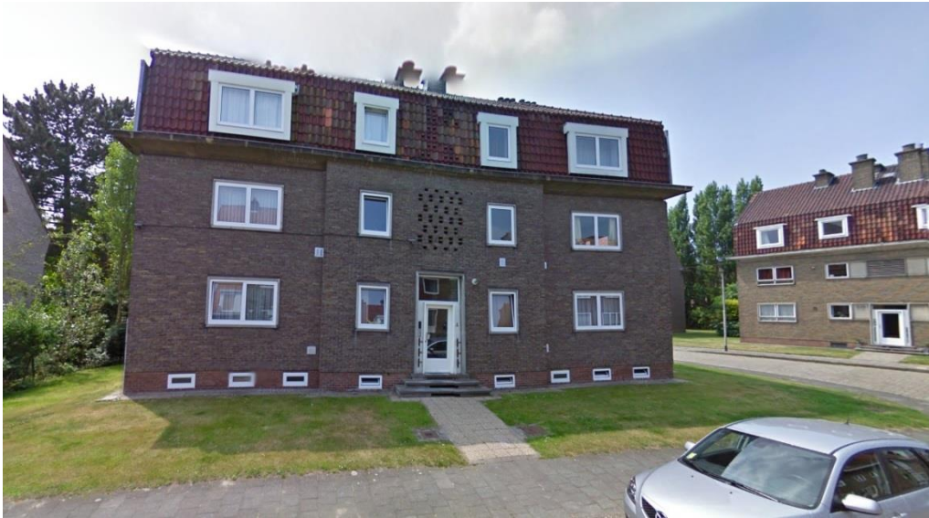
Figuur 72 Architect Jules Trenteseau, appartementsgebouw met 6 appartementen, Kievitlaan 8, 1960 (links) en appartementsgebouw met 6 appartementen, Parelhoenstraat 2, 1960 (rechts) 76
