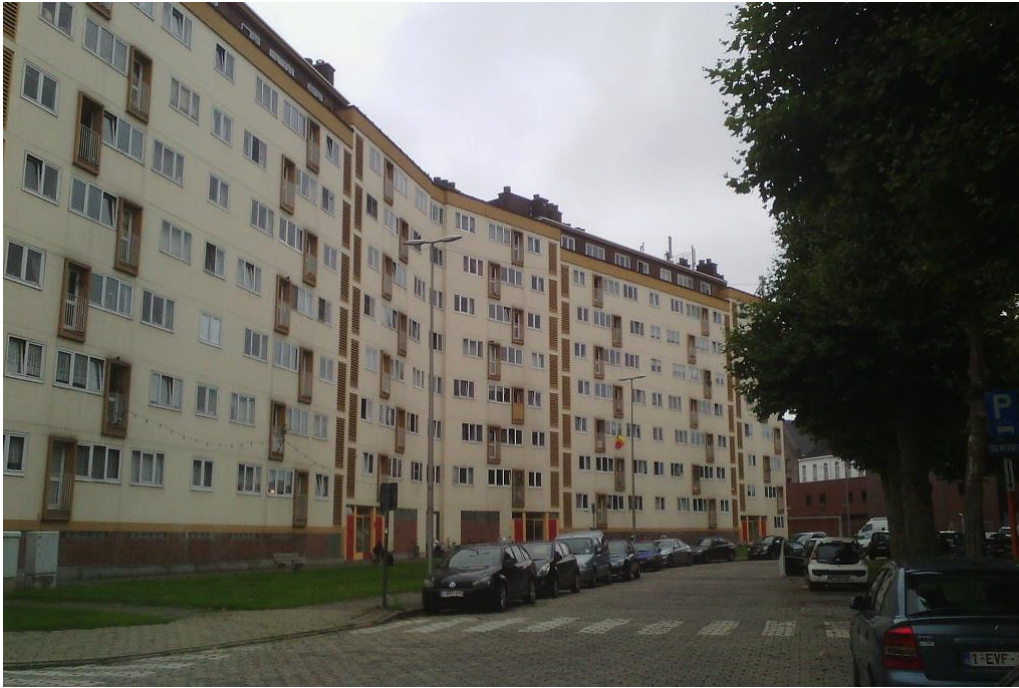
Figuur 39 Architect Jules Trenteseau, appartementsgebouw aan de Tichelrei, 1958 41
