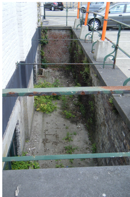
Fig. 25: Zicht op de minimale diepte van het kelderniveau
