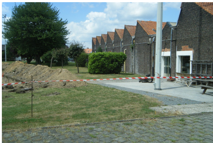
Fig. 26: Zicht op de bestaande bebouwing
