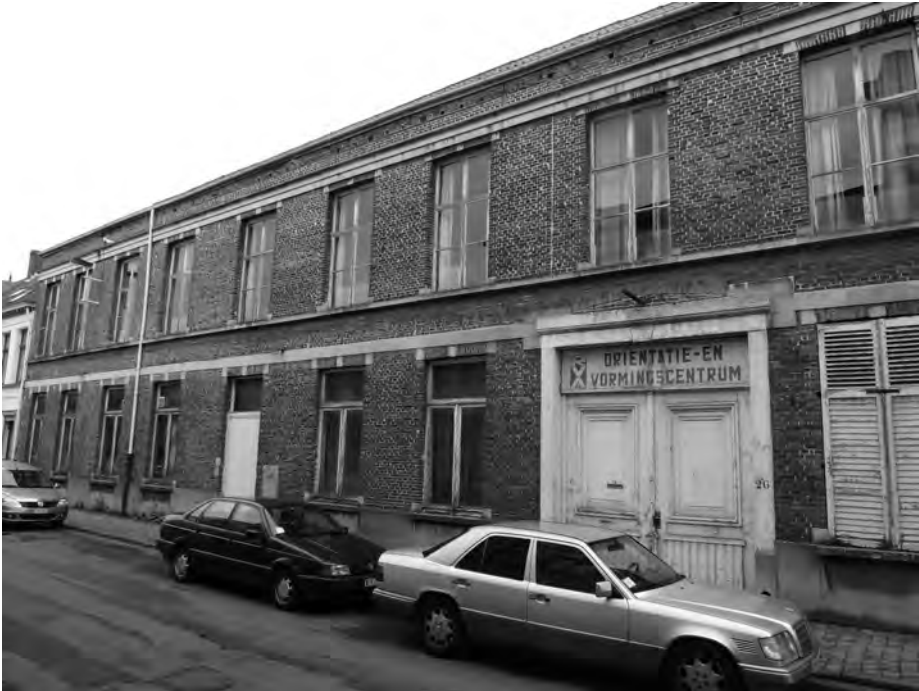
Afb. 1. Uitzicht anno 2013 Nieuwland nr. 26 (9 van de nog bestaande 13 traveeën: een travee is een zich herhalend element in de lengterichting van een gevel: venster- of deuropening, horizontale gevelindeling). In ontleisterde toestand met gecementeerde druiplijsten en vereenvoudigde kroonlijst. De uitspringende en doorlopende arduinen vensterbasis op de verdieping is een in de 19de eeuw veelvuldig aangebrachte wijziging bij oudere gebouwen. De gevel vertoont verschillende bouwnaden, sporen van opvulling van originele poorttoegang en uitbreidingen.
