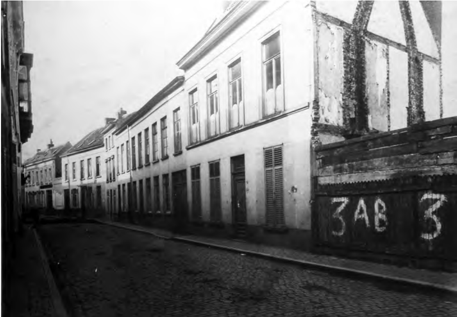
Afb. 6. Foto uit de verzameling van de Stedelijke Commissie voor Monumenten en Stedenschoon (SCMS 4071) bewaard in het Stadsarchief Gent. Een schijnbaar vreselijk banale gevelrij De afbraak is reeds begonnen. Het tweede huis van rechts (met negen traveeën) is het Bauwenshuis.
